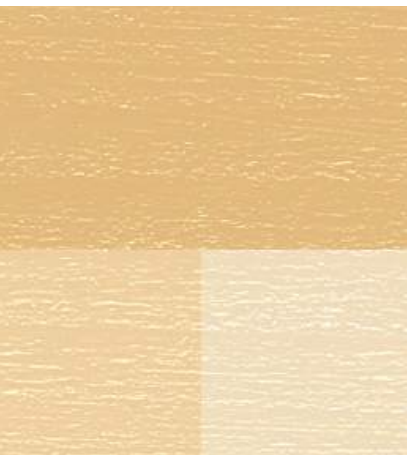
Alt 1 gavelfasad. Matrisgjuten yta i grovt trämönster för hög skuggverkan. målas i ockrafärgad kulör.
